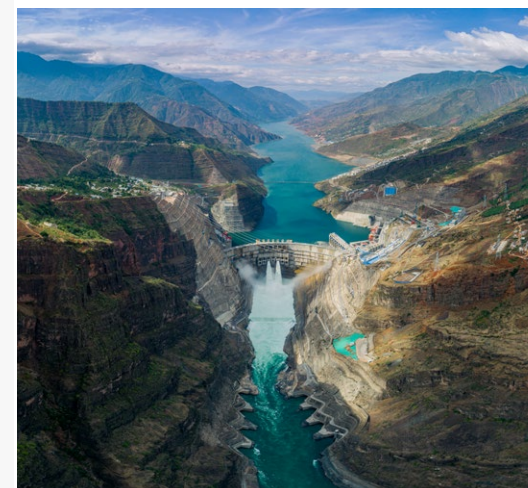
微膨胀低热硅酸盐水泥成功应用于白鹤滩水 电工程
